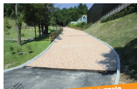
Accesso adiacente al piazzale del supermercato
