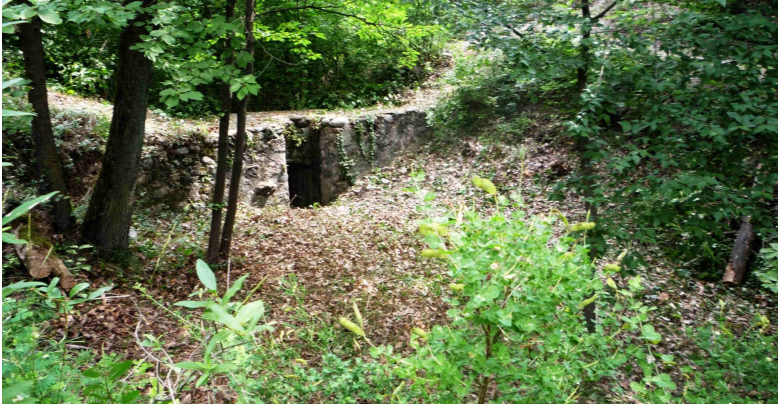
La Guja di Bric Castlètt lungo il Sentiero della Calce
