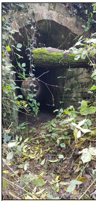
INTERVENTO 2 FOTO 07 Immissione fosso di scolo nel Rio
