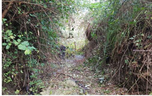
INTERVENTO 1 FOTO 03 Vista dell'alveo e sponde in erosione
