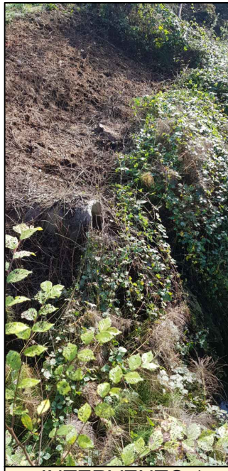
INTERVENTO 1 FOTO 04 Tubazione di scarico acque nel Rio
