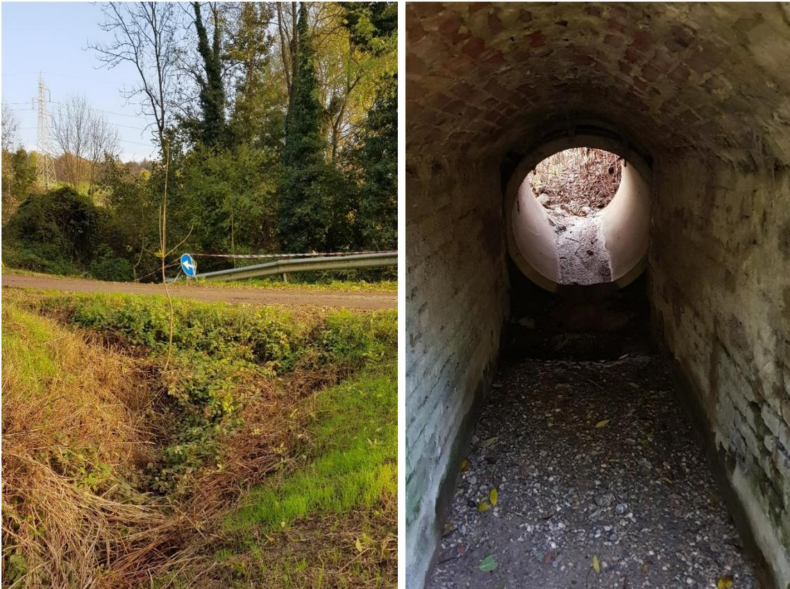
*Figura 10 - Attraversamento di Via Casabianca, costituito da tubazione di imbocco con diametro interno 0.9 m, e manufatto ad arco in mattoni, di luce maggiore.*
