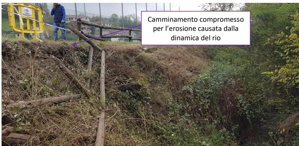
*Figura 3 – Vista verso valle del Rio Baldissero in corrispondenza del tratto con la sponda sinistra in erosione e vista del percorso pedonale coinvolto.*
