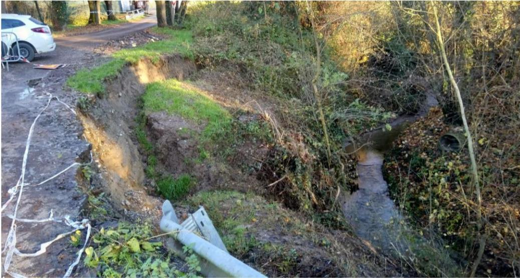
*Figura 9 - Vista dell’aggravamento del franamento della sponda del rio Baldissero lungo via Casabianca a seguito di precipitazioni intense.*
