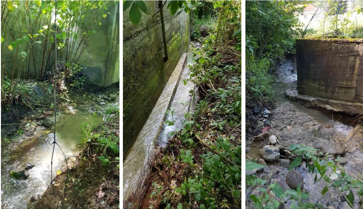
*Figura 7 – Evidenti segnali di criticità per processi erosivi e insufficienza della sezione d'alveo.*
