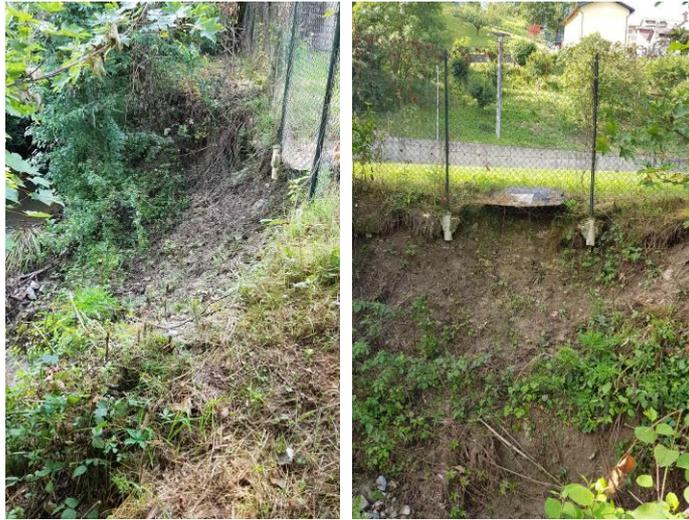
*Figura 21 – Processi erosivi della sponda e danneggiamento parziale della recinzione.*
