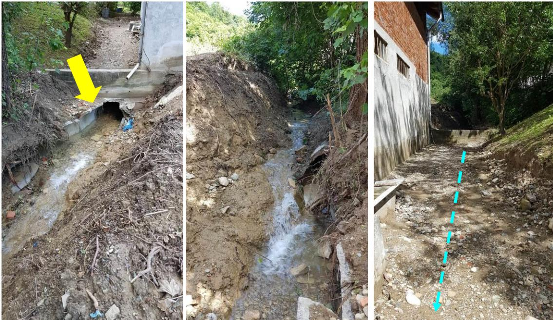
**Figura 5 – Da sinistra: punto di occlusione (ora sgomberato) visto da monte e tratto immediatamente a monte, tratto intubato visto da valle.**
